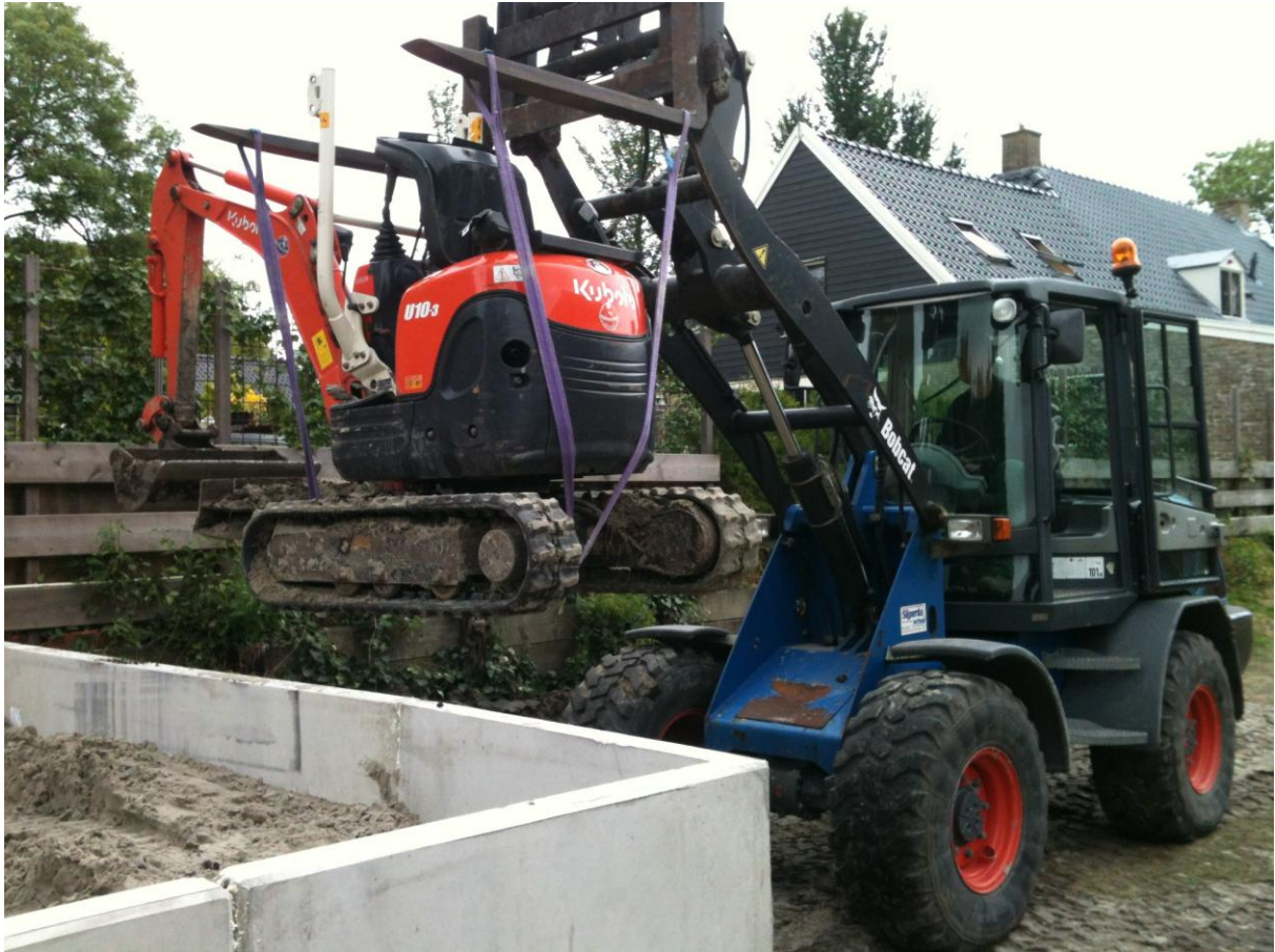
Met een shovel komt de minikraan op de juiste plaats om de klus te klaren
