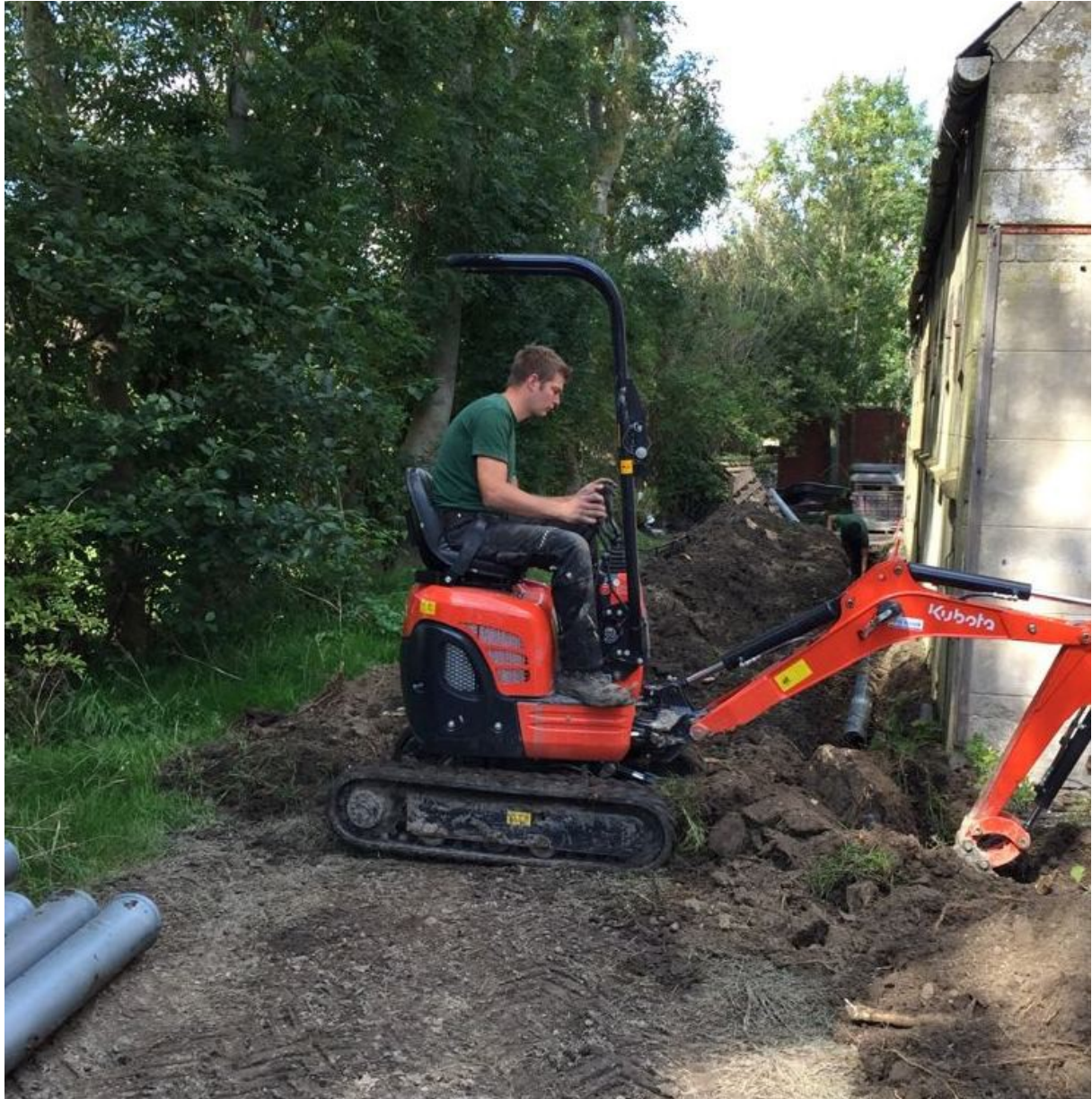
Ook voor graafwerk zijn het nu nog geschikte weken. Hier vernieuwing waterafvoer.
