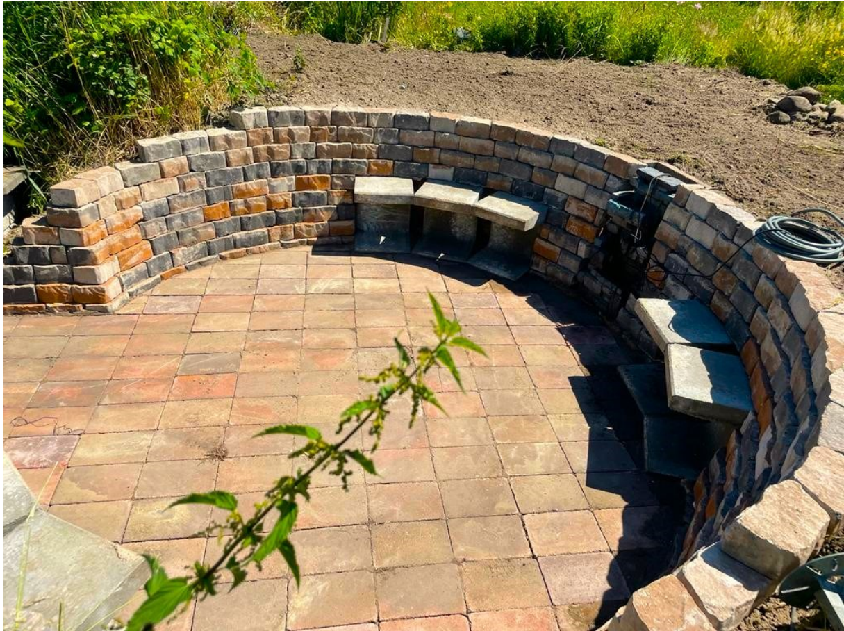
Foto: gebruik hoogteverschillen in de tuin, zoals deze kortgeleden aangelegde zithoek. Gemaakt van verschillende soorten bestrating en stenen. Verder een mini-waterval in het midden. De afwerking volgt nog met verlichting en beplanting.
